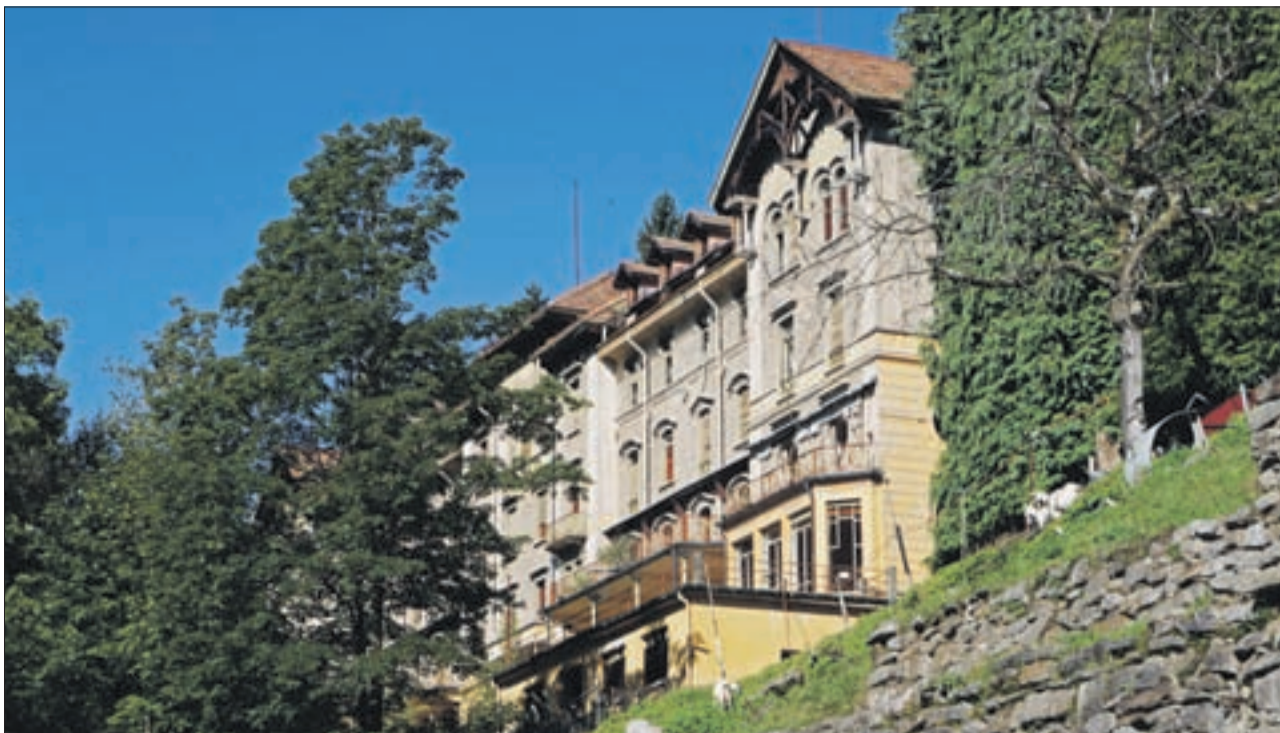
Soll in eine Eliteschule umgewandelt werden: Das seit 1962 leer stehende Sanatorium von Piotta.
